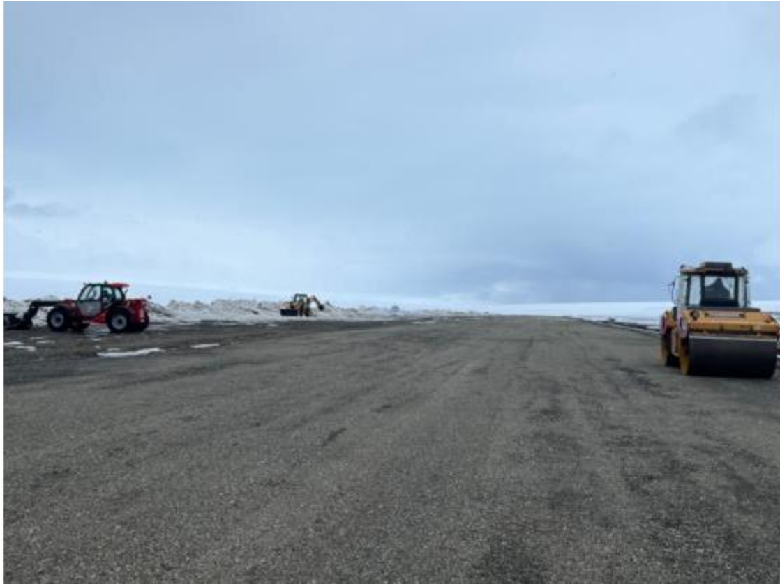
TRABAJOS DE RELLENO DEL PAQUETE ESTRUCTURAL Y COMPACTACIÓN EN CABECERA 21 – ALTURA 900 METROS
