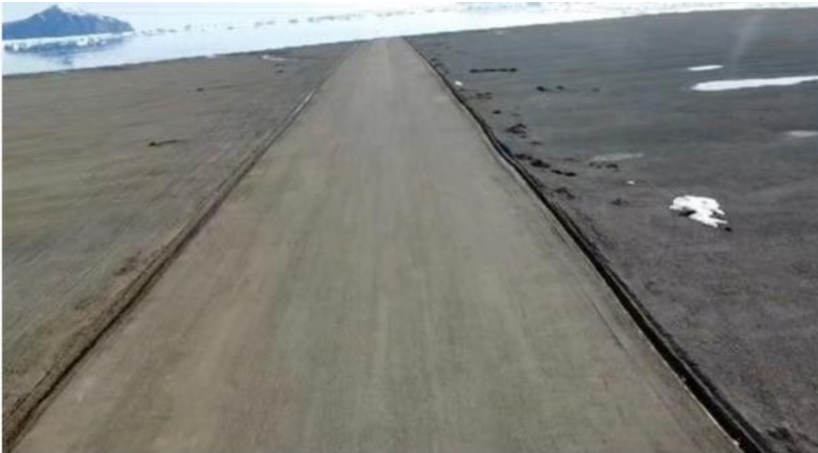
VISTA DE LA PISTA DE ATERRIZAJE TERMINADA
