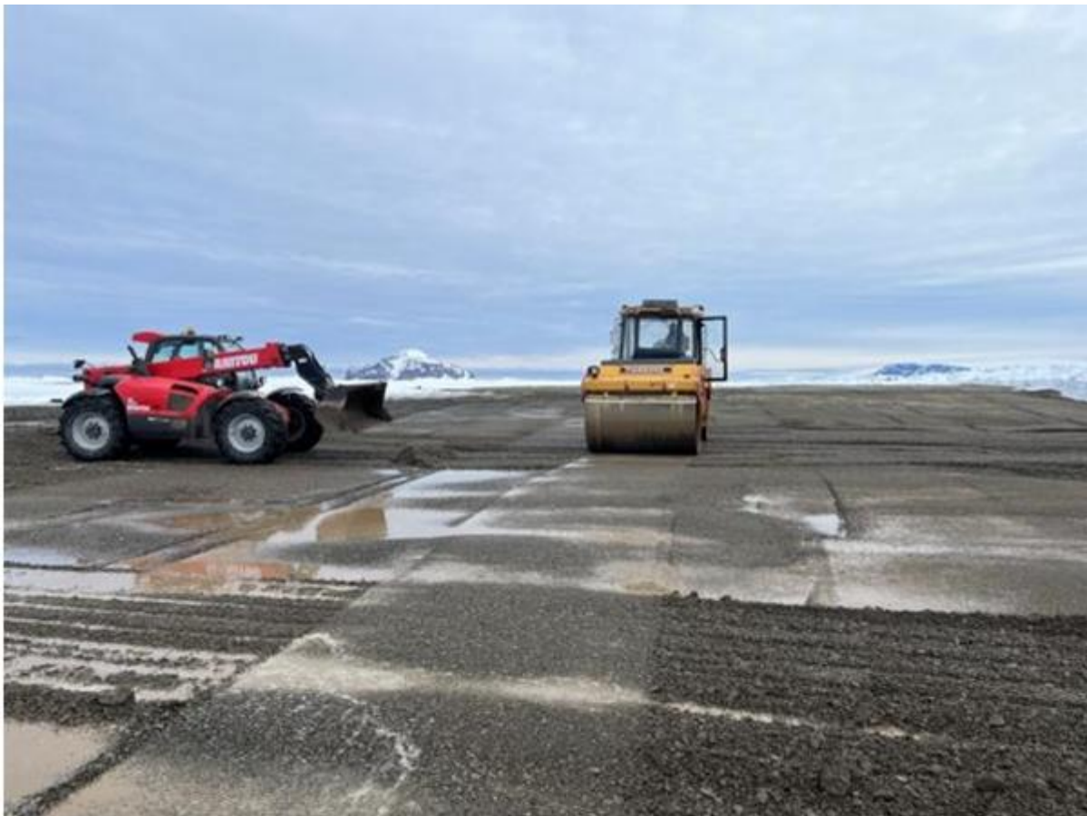
TRABAJOS DE RELLENO DEL PAQUETE ESTRUCTURAL Y COMPACTACIÓN EN CABECERA 21 – ALTURA 900 METROS
