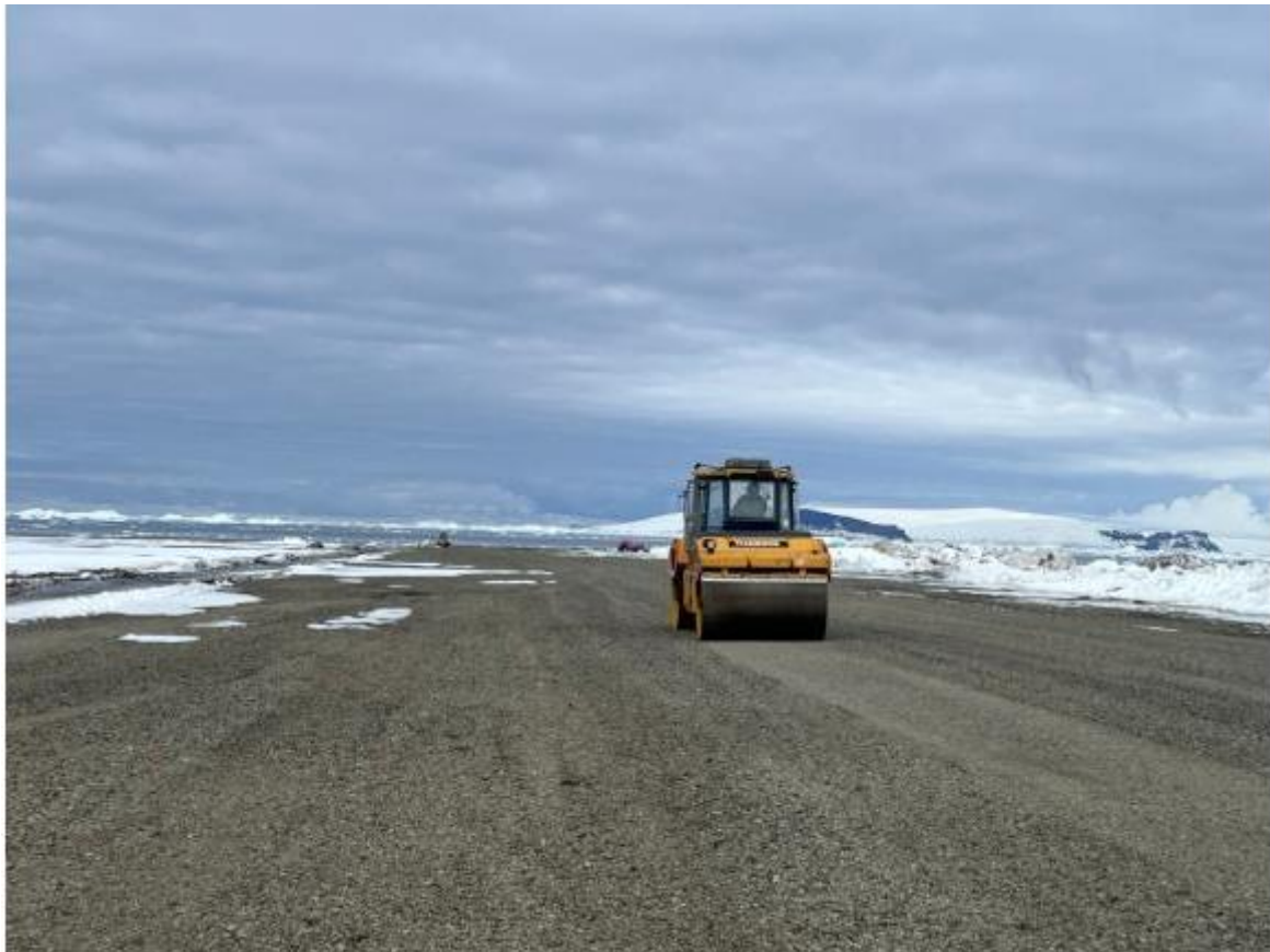
COMPACTADO DEL PAQUETE ESTRUCTURAL DE LA PISTA DE ATERRIZAJE DE 1100 METROS DE LARGO X 40 METROS DE ANCHO.
