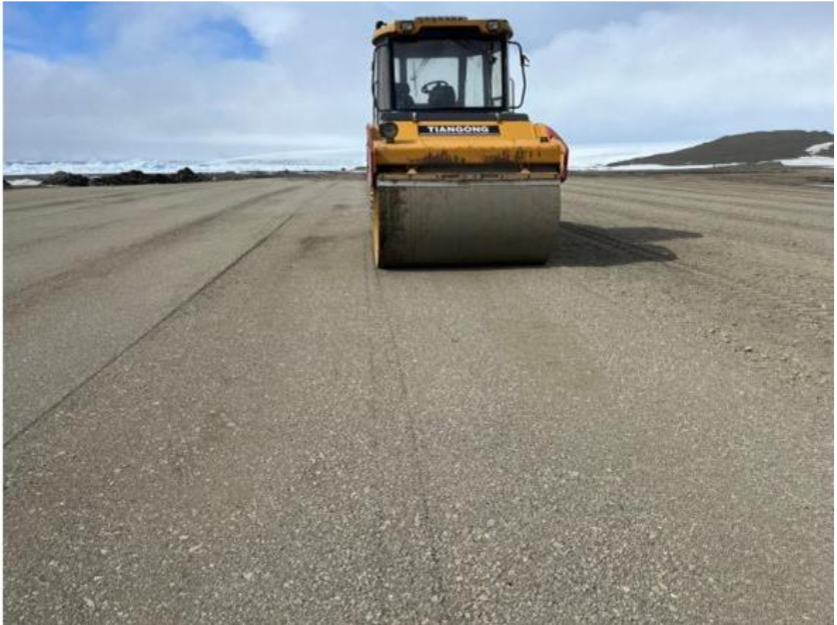
CONSTRUCCIÓN DE LA PLATAFORMA DE RODAJE DE 30MTS X 30 MTS CON LOS CARTELES DE AERÓDROMO ANTARTICO BASE PETREL, DE PLATAFORMA, DELIMITACIÓN Y CAMINOS DE ACCESOS.
